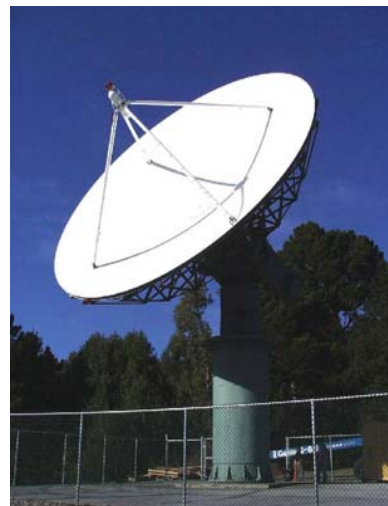
BGS 11m Antenna
